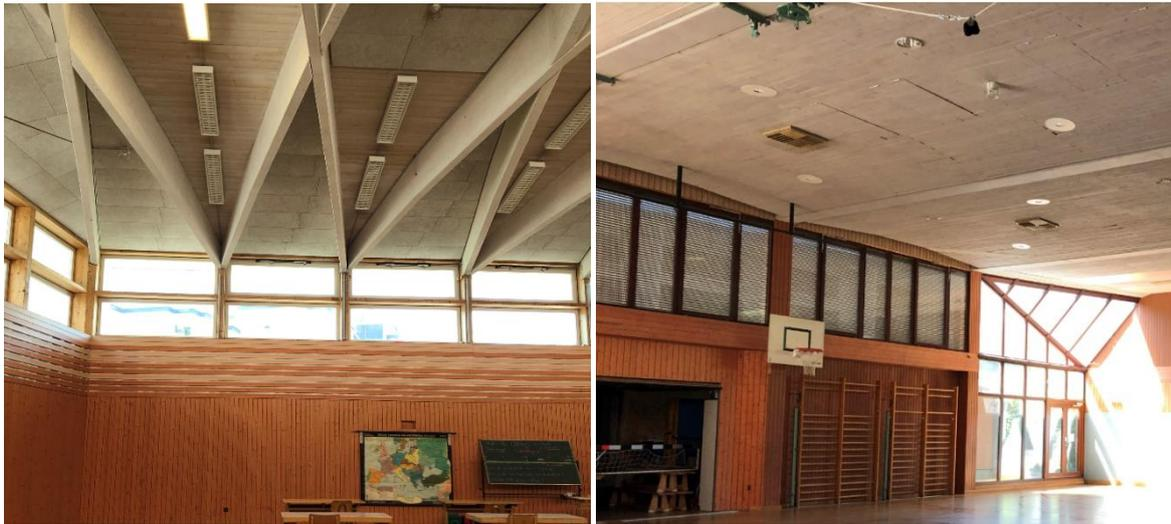
Abbildung 6: **links:** Turnhalle 1 mit T8 Leuchtstoffröhren; **rechts:** Turnhalle 2 mit LED-Beleuchtung
