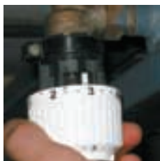
Die Optimierung der Heizungs- und Lüftungssteuerung war eine sehr wirtschaftliche Maßnahme innerhalb des ECO-Watt-Projekts.
