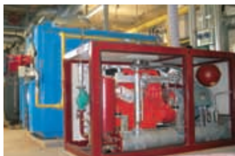
Der neue Heizkessel und das BHKW im Solar- und Sparprojekt, Europaschule Köln
