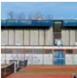
42 m 2 Solarkollektoren erwärmen das Duschwasser in der Sporthalle
