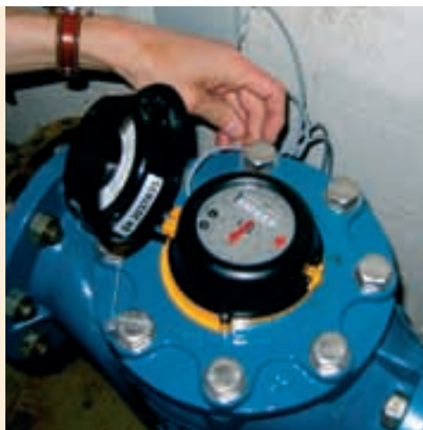
Der Blick auf den Wasserverbrauchszähler zeigt auch hier ein enormes Einsparpotenzial
