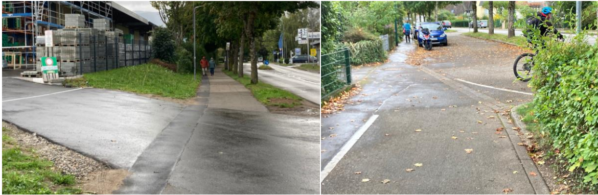
Abbildung 48: Gefahrenstellen auf der Zartener Straße von Zarten zur Realschule am Giersberg.
