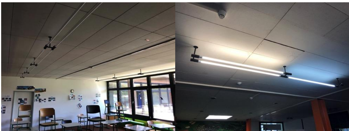
Abbildung 16: Nicht saniertes Klassenzimmer mit T8 Leuchtstoffröhren – ohne Leuchtkörper
