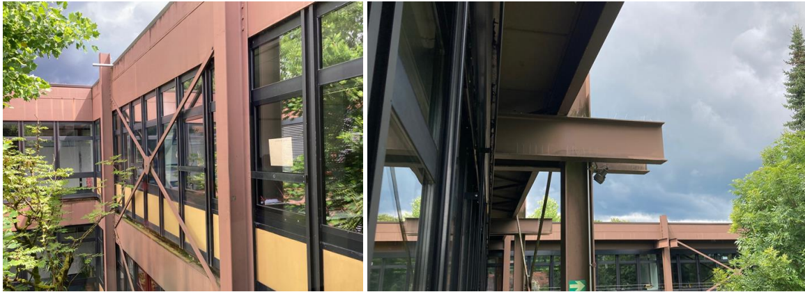
Abbildung 10: Außenhaut und tragende Stahlträger der Realschule am Giersberg
