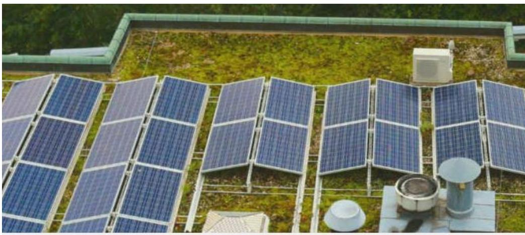
Abbildung 31: Beispiel für eine PV-Anlage mit Ost-West Ausrichtung und flach angebrachten Modulen, die eine möglichst geringe Angriffsfläche für den Wind bieten.
