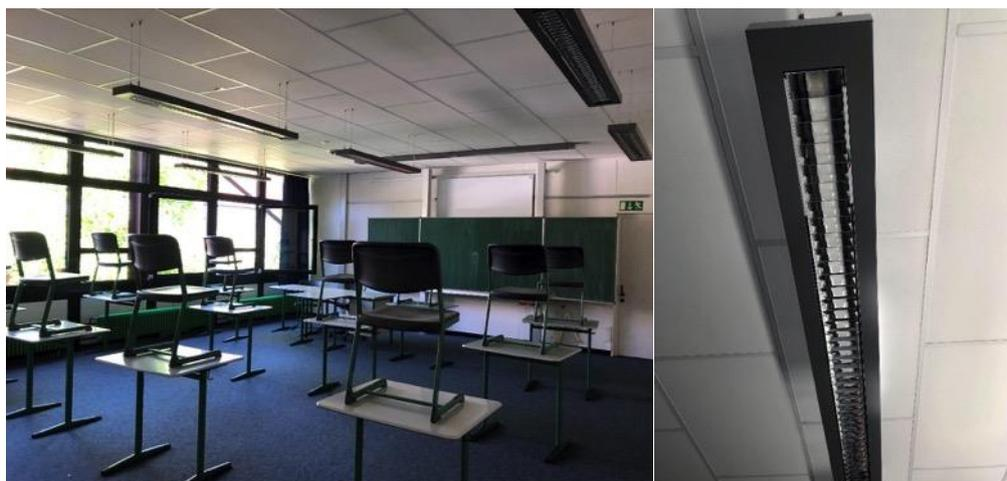
Abbildung 17: **Links:** Klassenzimmer mit saniertem Beleuchtung **Rechts:** Moderne Leuchte mit LED-Technik
