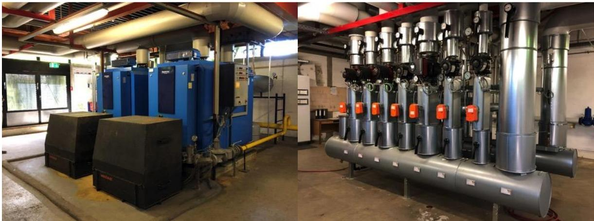
Abbildung 9: Links: Heizungsanlage des Schulzentrums Dreisamtal, bestehend aus zwei Gas- /Ölbrennern mit Baujahr 1982 und zwei Heizkesseln mit Baujahr 1997 (blaue Farbe) Rechts: Wärmeverteilungssystem
