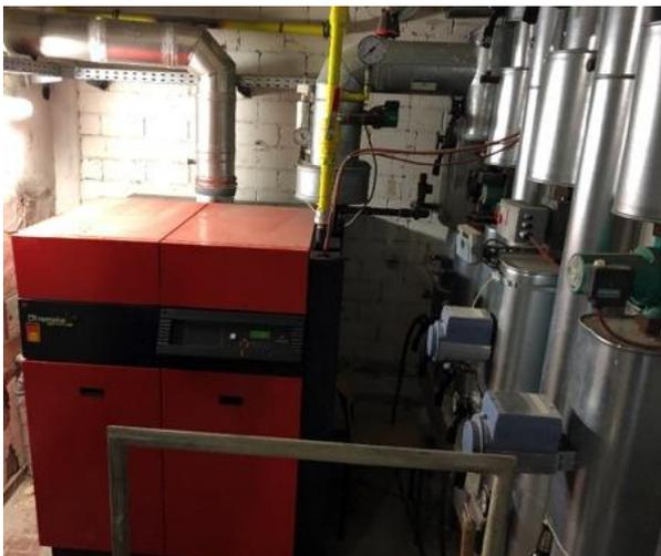
**Abbildung 6: Heiztechnik für Turnhalle, Gas-Boiler**
