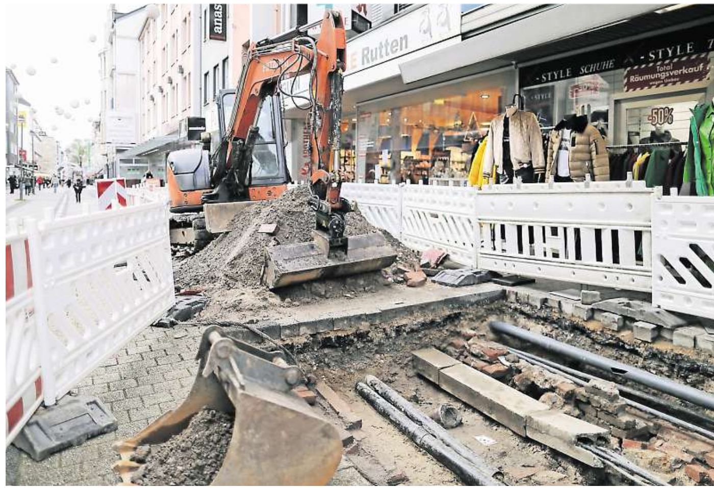
Gegenüber des Schwobodroms fand eine erste archäologische Suchgrabung statt.
