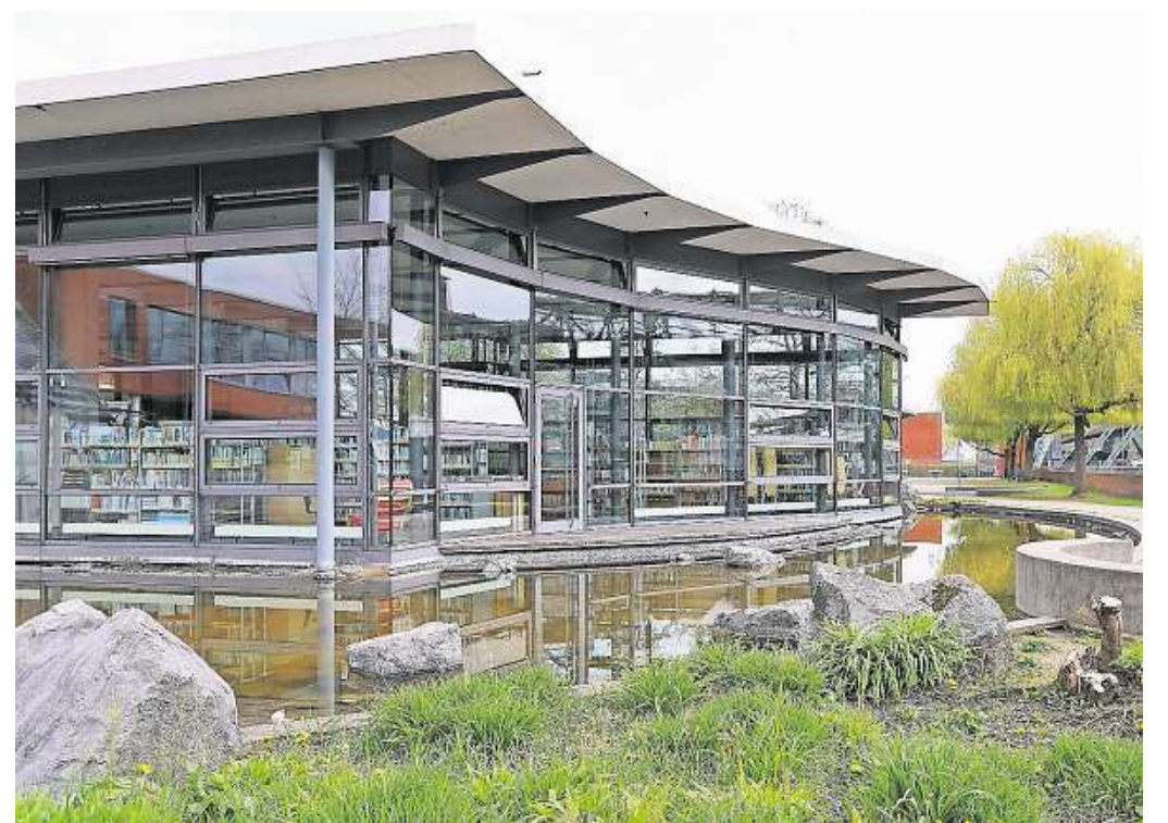
Die Gesamtschule Barmen bekommt im Frühjahr eine Photovoltaik-Anlage.
