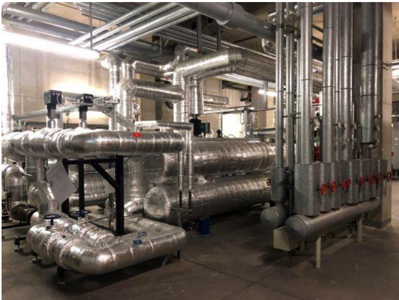
Abbildung 4: Fernwärmeübergabestation.
