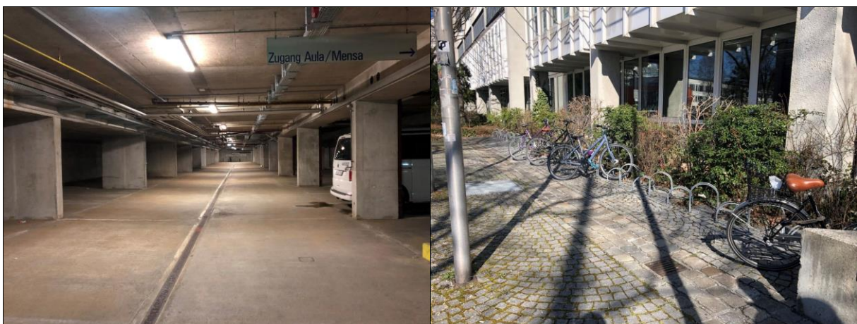
Abbildung 25: Links: Tiefgarage mit 110 Abstellplätzen für Autos, Rechts: Abstellplätze für Fahrräder vor dem Schulgebäude.
